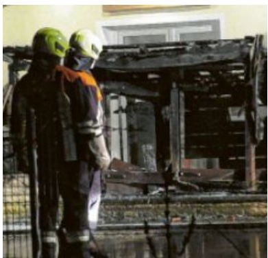
In Feldheim ist ein Mülltonnenhäuschen abgebrannt. Foto: Martin Wiemann
